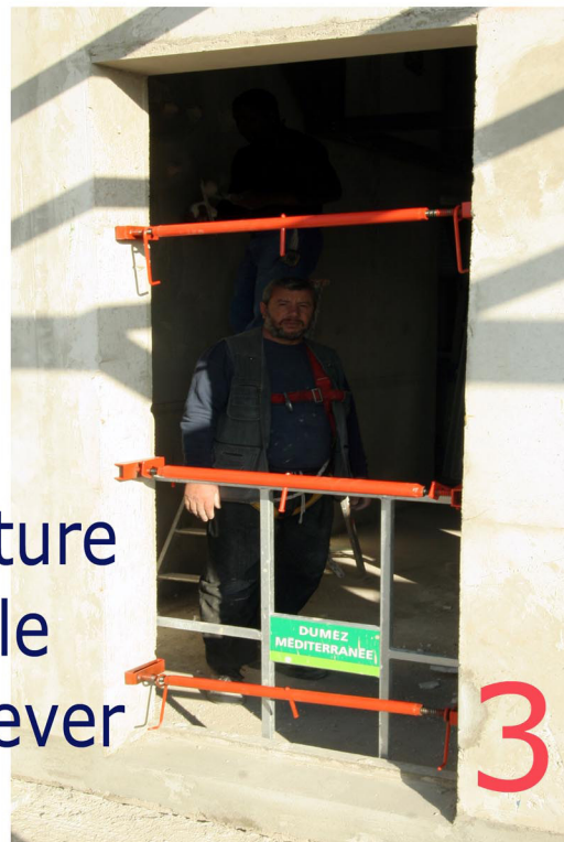
Le menuisier commence par poser une PCM supérieure
